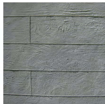
Die detailgetreue Wiederherstellung der Brettstruktur bedingt ein akribisch genaues Arbeiten
