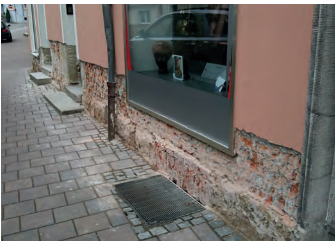
Vor Beginn der Arbeiten (Vorher)
