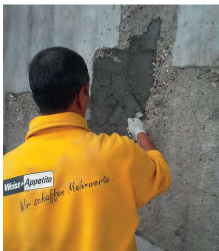
Spezialisierte Betoninstandsetzung – Auftrag des Instandsetzungsmörtels
