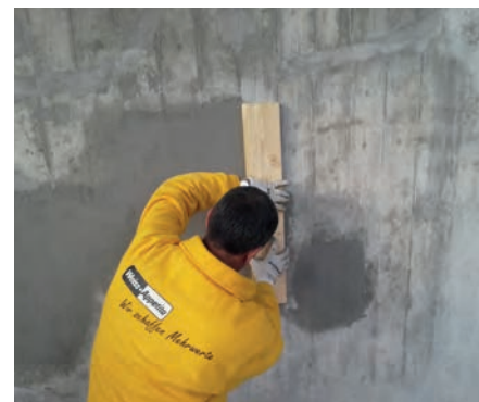
Auftrag der Spachtelmasse und Erstellung der Brettstruktur
