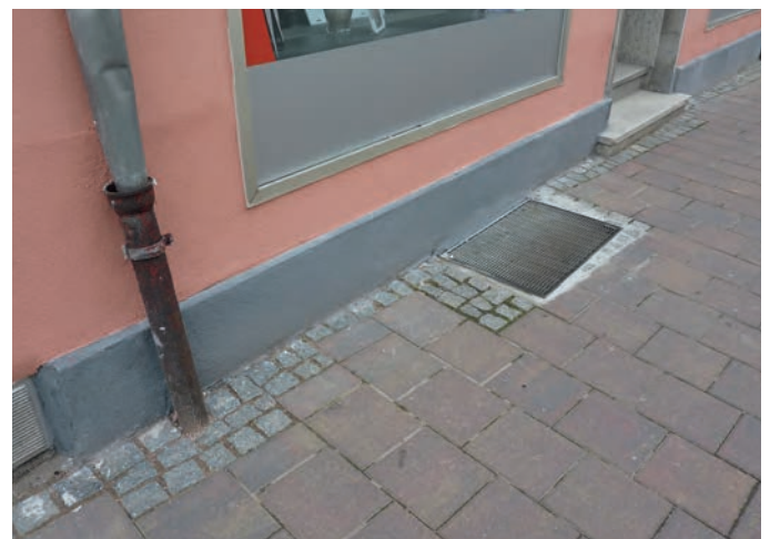
Mauer nach Abschluss der Arbeiten (Nachher)
