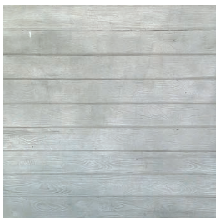
Die detailgetreue Wiederherstellung der Brettstruktur bedingt ein akribisch genaues Arbeiten
