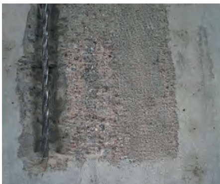
Sorgfältige Reinigung der korrodierten Armierungseisen
